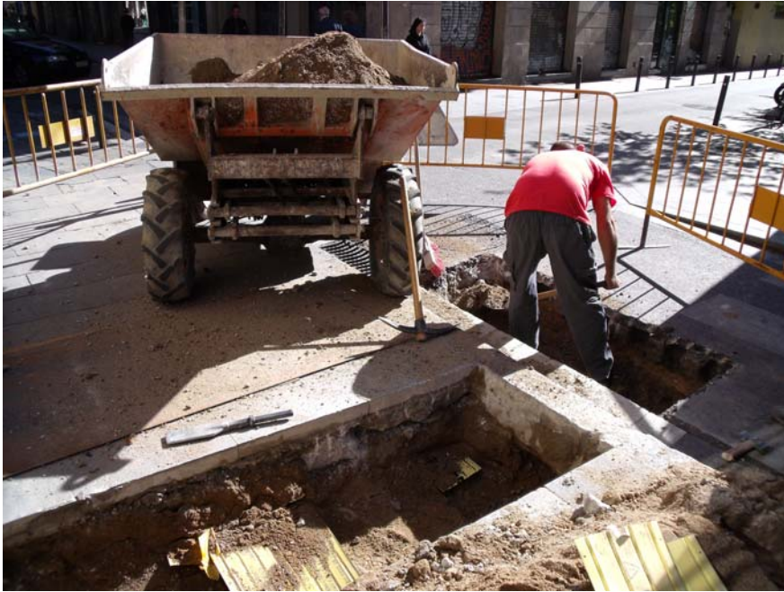
Fotografia número 1. Detall de l'excavació de les rases.
