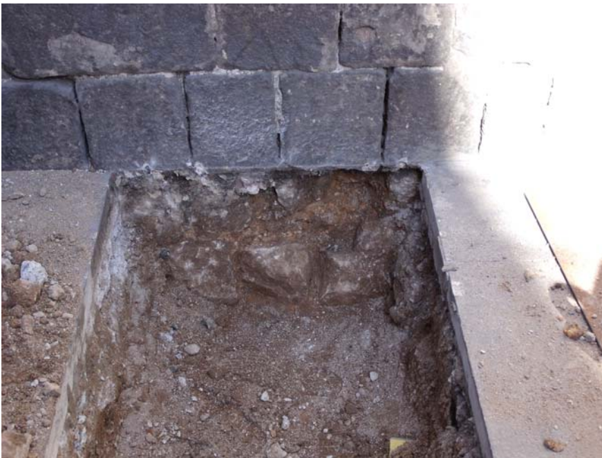
Fotografia número 4. Detall de dues filades de la fonamentació del mur de façana.
