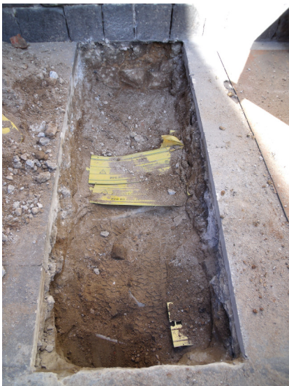
Vista de la rasa de vorera en procés d'excavació.
