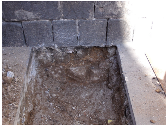
Detall de la fonamentació del mur de façana de La Capella.
