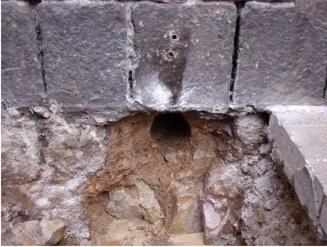
Detall del mur i la fonamentació, un cop perforat.
