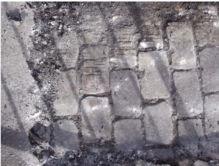
Fotografia número 2. Vista del paviment de llambordes del carrer.
