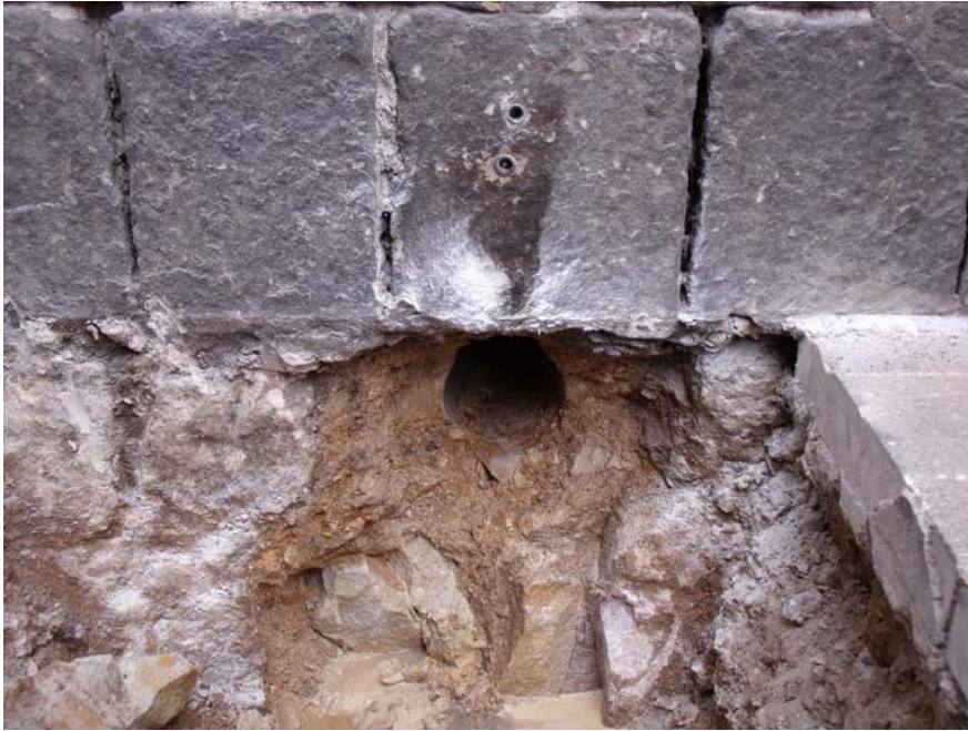
Fotografia número 5. Detall de la perforació de la fonamentació.
