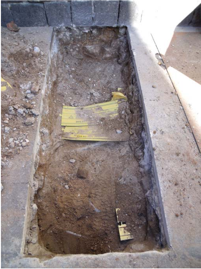
Fotografia número 3. Vista de la rasa realitzada a la vorera.
